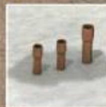
Lekkage bij doorvoeren van bijv. leidingen
